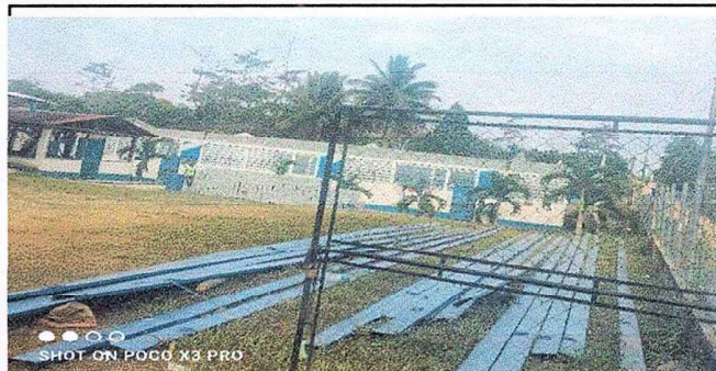
Foto 2: Mantenimiento de estructuras metalicas.
