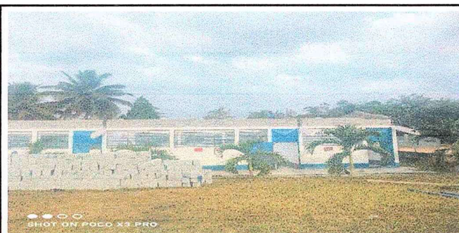
Foto 3: Levantamiento de tres hiladas de block
